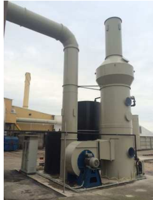
Figure 4 - Tour de lavage à média flottant (source : Galli Aldo)
