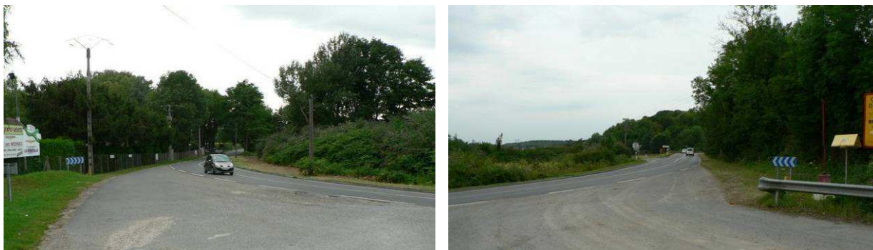
Figure 12 et Figure 13 - RD 44 au droit de l'accès au site (vue vers l'Ouest, à gauche, et vue vers l'Est, à droite)
